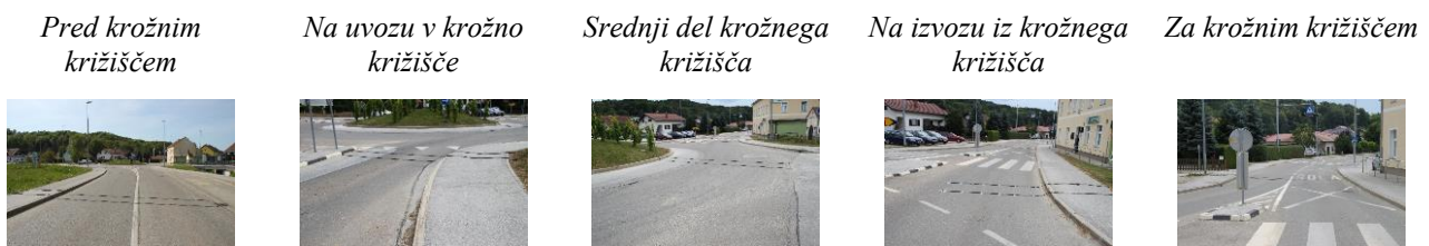
Slika 3. Prikaz postavitve pnevmatskih cevi na vozišču v posameznem prerezu – npr. v krožnem križišču Juršinci [3]
