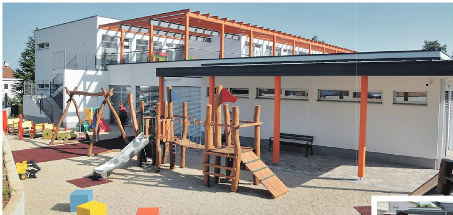
Vrtić je u roku od 220 dana izgrađen u obliku drveno-montažne građevine
