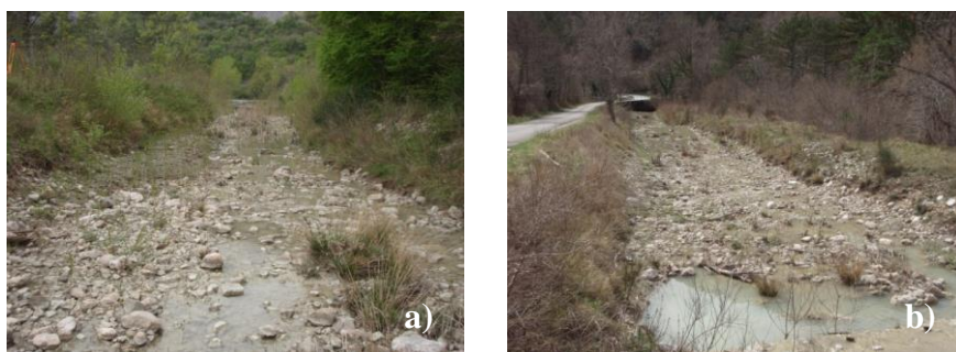
Slika 4.24. Pogled na vodotok Slani potok: a) uzvodno od gornje taložnice, b) nizvodno od donje taložnice (Foto: Elvis Žic)
